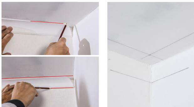
2. Отметьте на изделиях места среза для соединения углов.
